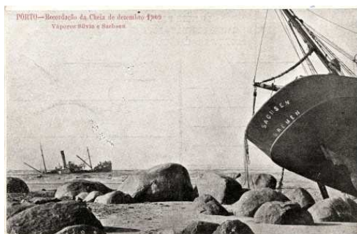
Fig. 14 – Destroços de barcos. Porto
